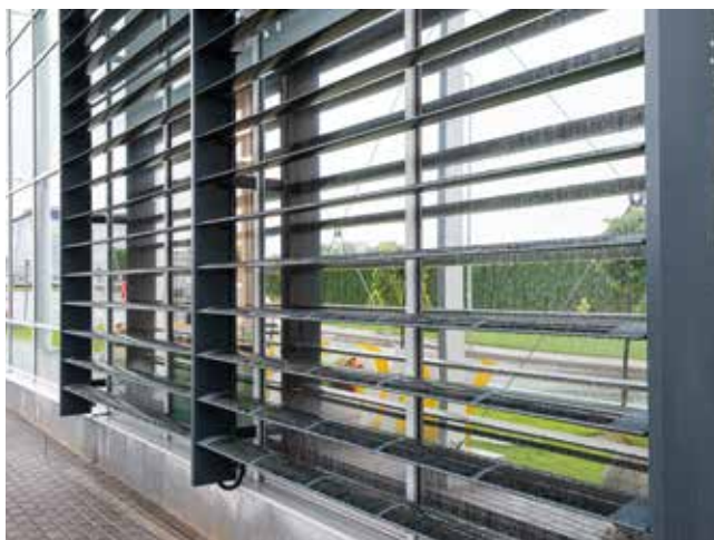
Lamele-łamacze światła na fasadzie budynku Aliplast
